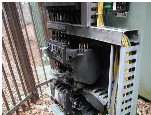
雷で破損した盤
